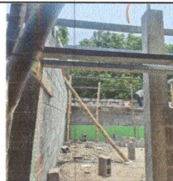
Foto 4: Reparación y levantado de muro de Block
