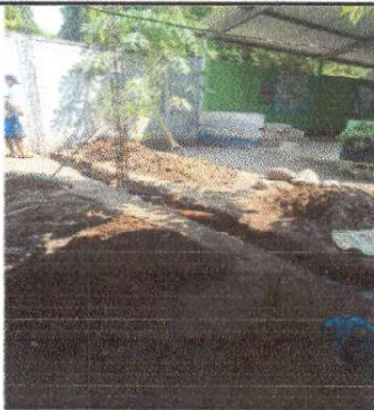
Foto 3: Reparación y levantado de muro de Block
